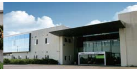
沖縄健康バイオテクノロジー研究開発センター 沖縄工業技術センター アネックス
